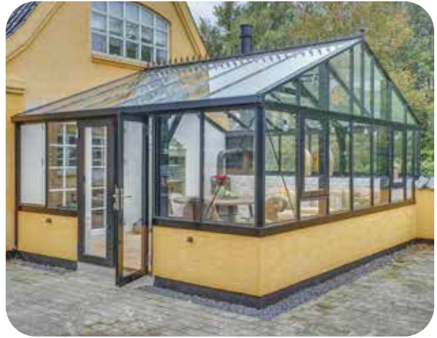
tegen muur en op muur / contre et sur un mur
